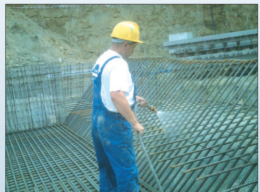
Fot. 2. Utwardzanie Hydrostopu przez zraszanie na „skosach”
