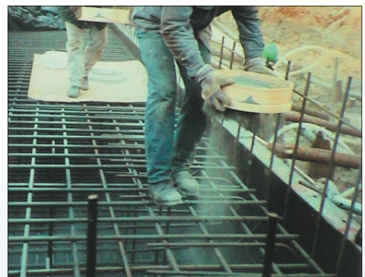
Fot. 1. Wykonywanie posypki
