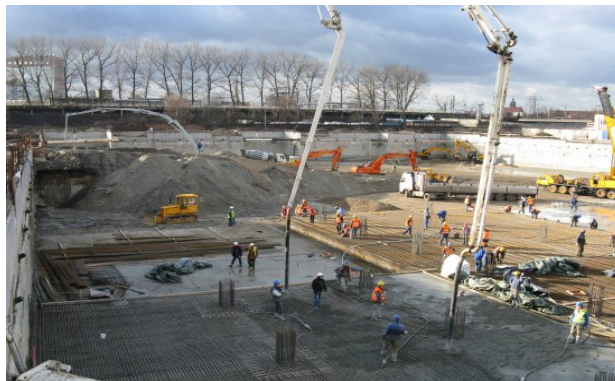
Fot. 1 Podziemia uszczelnione Hydrostopem.
