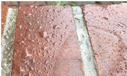
Fot. 3: Murek zaimpregnowany Hydrostopem-Przezroczystym . Widoczne krople stojące na impregnacji. Fragment powierzchni był w trakcie opadu deszczu osłonięty obłym przedmiotem dzięki czemu widoczna jest różnica pomiędzy powierzchnią zmoczoną i powierzchnią osłoniętą.
