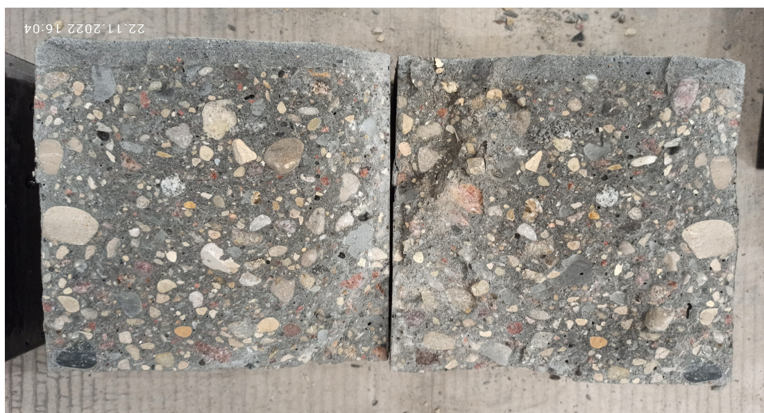
Fot. 4 Widok próbki z wariantu H-Plast po rozłupaniu. Nie stwierdzono oznak przecieku.
