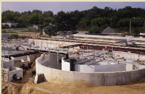
Fot. 1. Pierwsza oczyszczalnia ścieków uszczelniona w Polsce powłoką penetrującą. Nakładanie produktu Hydrostop, Mińsk Mazowiecki, rok 1987
