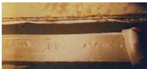
Fot. 1. Ilustracja uszczelnienia całej powierzchni cienkiej niezbrojonej wylewki w zbiorniku przeciwpożarowym.
